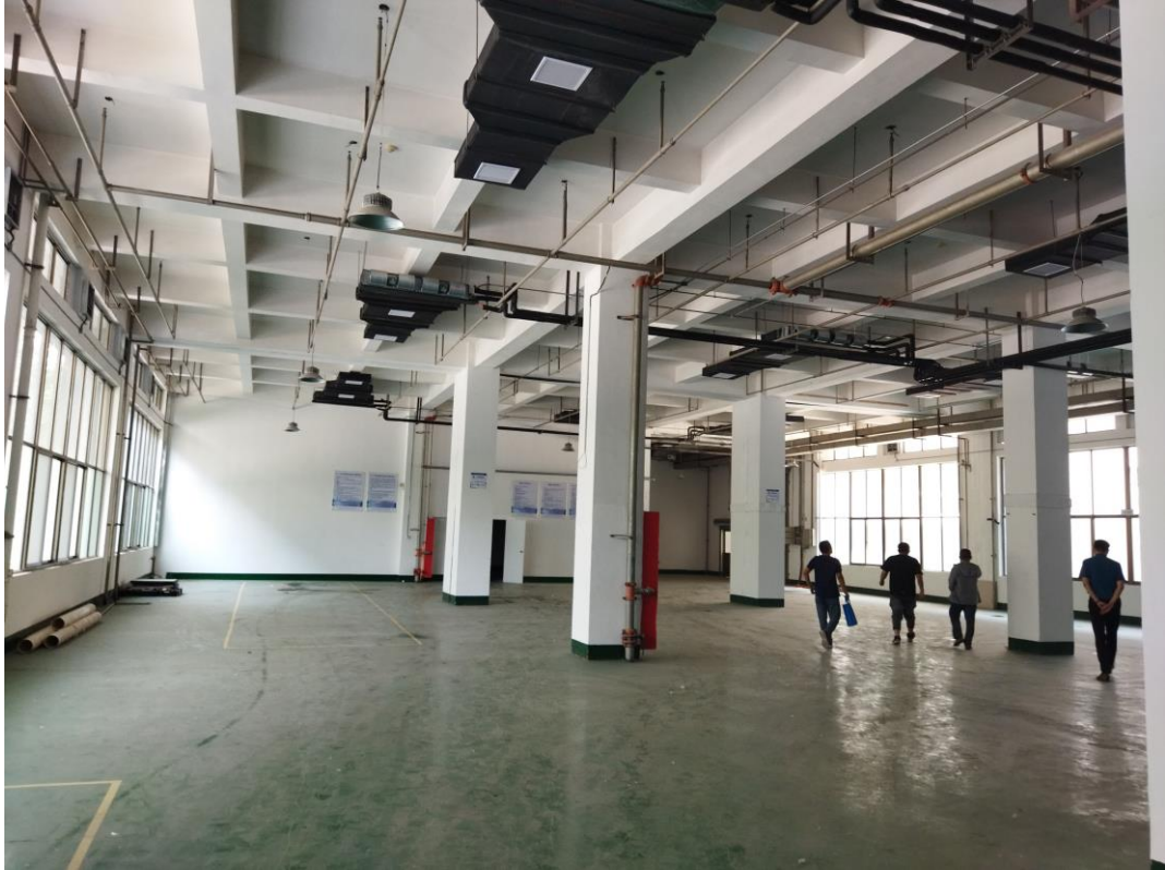
图3 本项目租赁车间现状图
